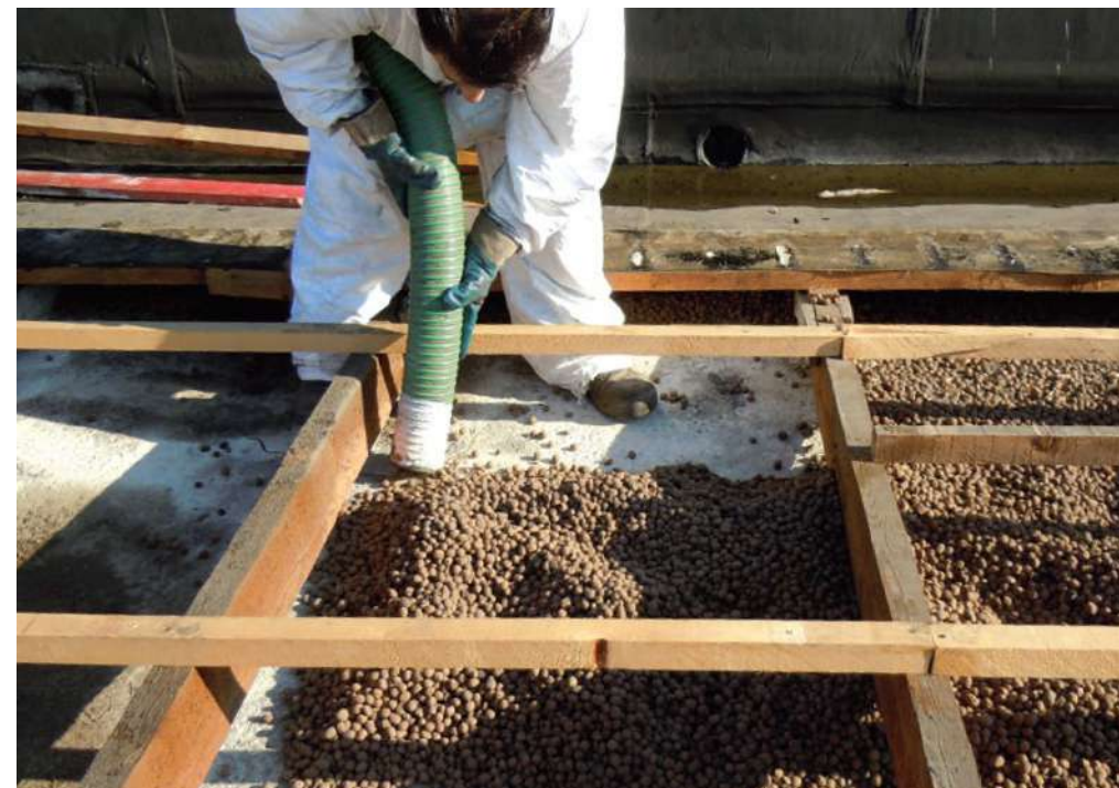
Recuperación de arcilla expandida para reciclaje tras su uso como aislante en cubierta plana
